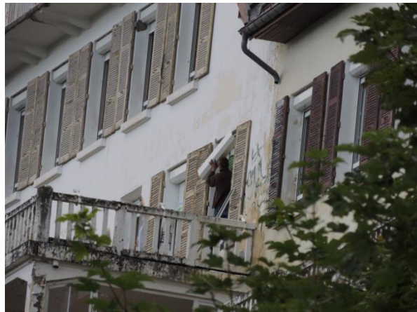
Figure 8 -Artisan récupérant des coffrets de volets roulants
