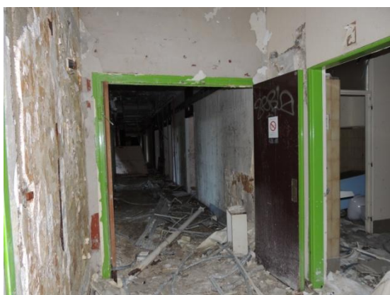
Figure 4 - Couloirs de l'un des établissements
