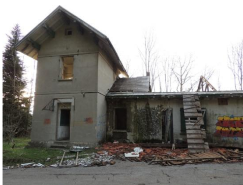
Figure 2 - Maison d'habitation dont le toit a fait l'objet d'une récupération de matériaux
